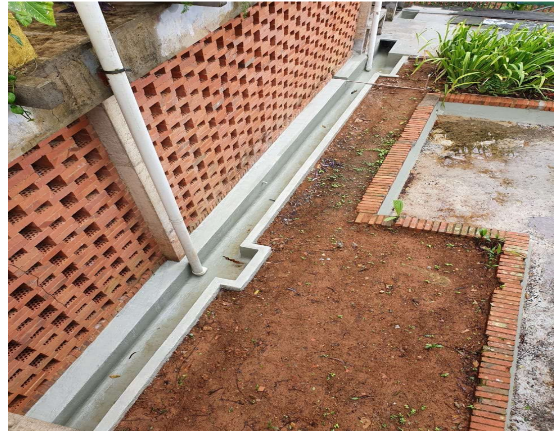
Calhas após recuperação
