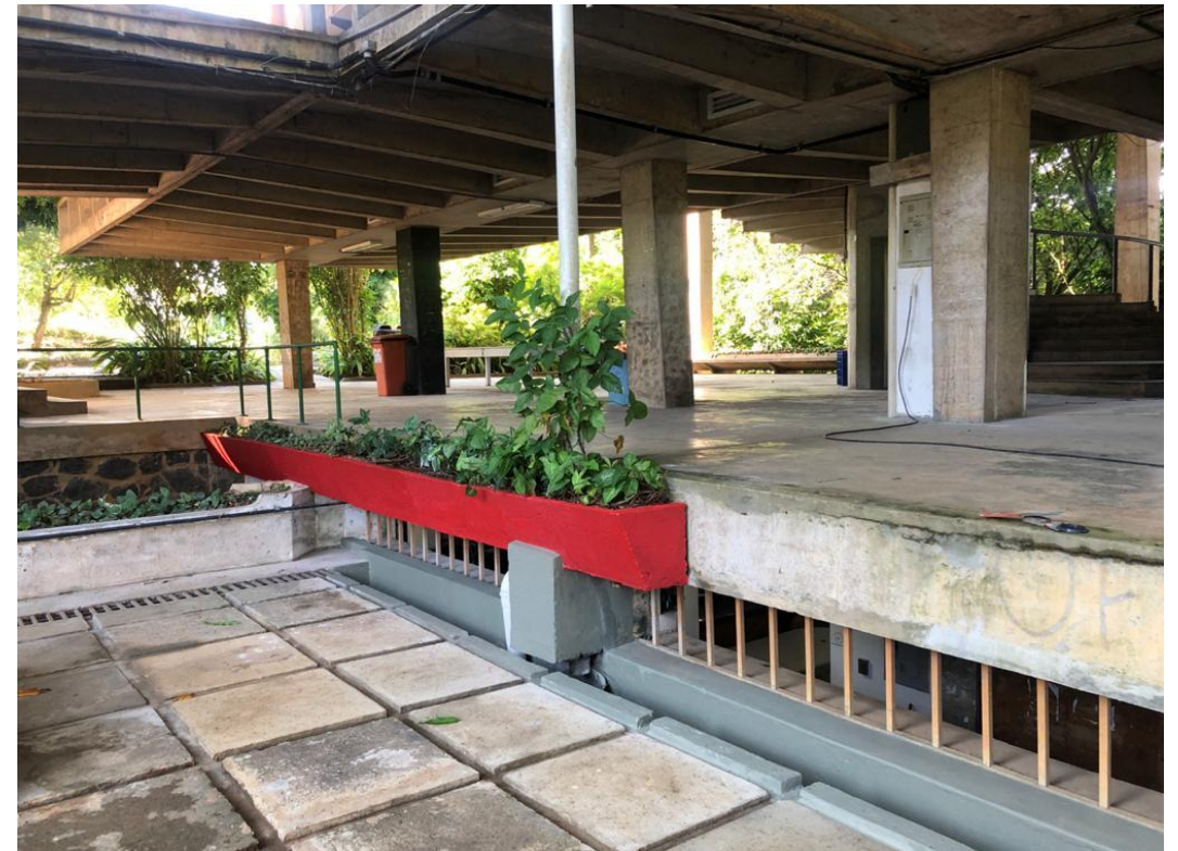
Recomposição e pintura das paredes da jardineira
