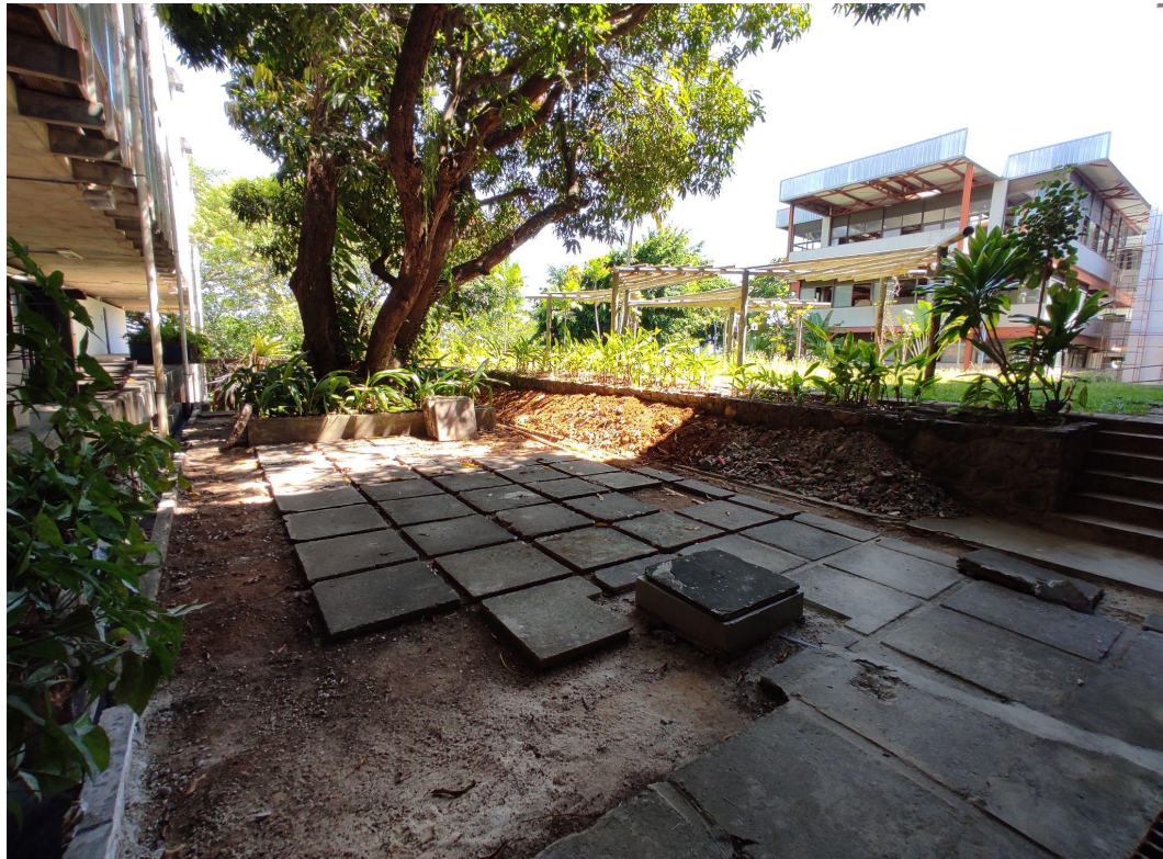
Recomposição do piso e caixa de passagem das instalações elétricas
