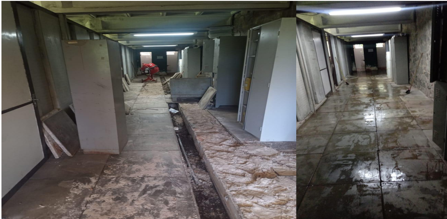
Subsolo módulo lansã, antes e depois das obras para retirada de raízes e limpeza de calhas.
