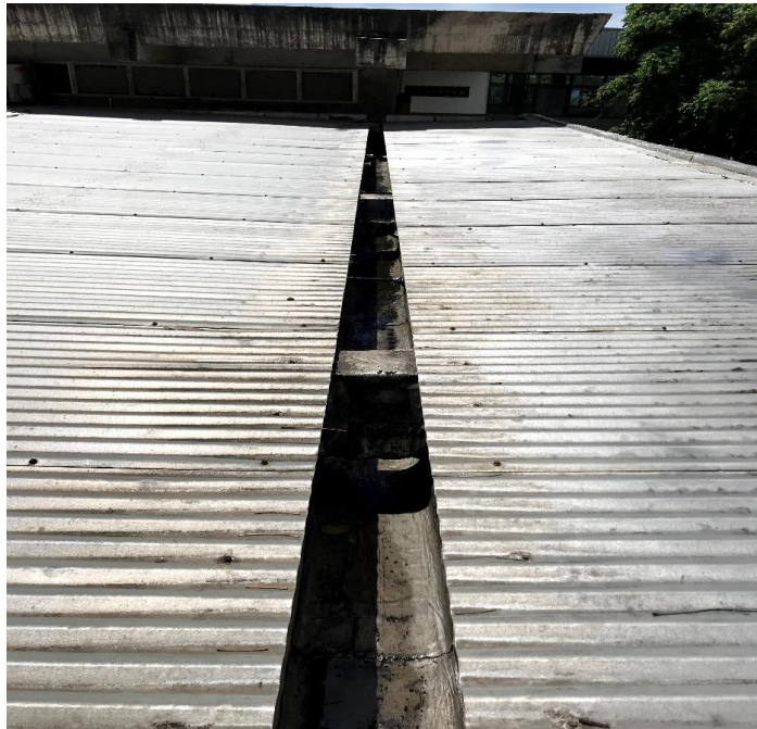
Limpeza das calhas sobre o Auditório I
