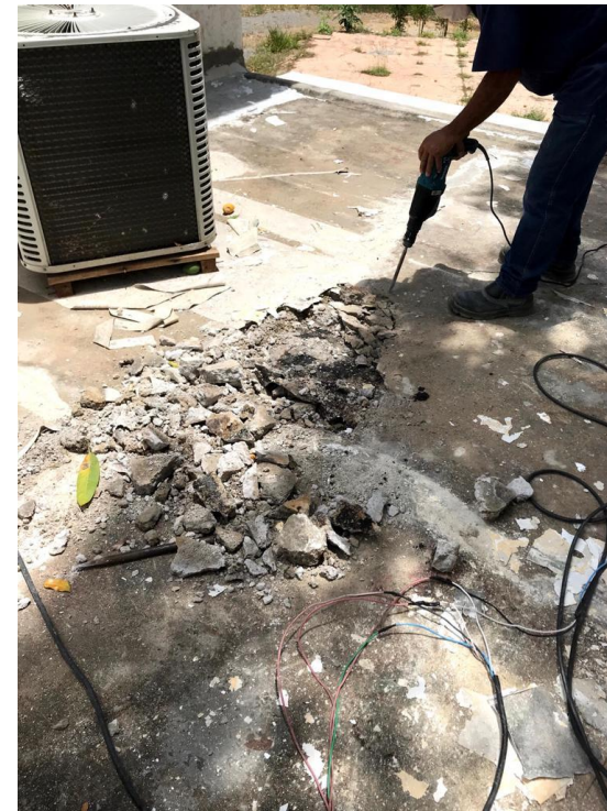
Retirada de contra piso e manta asfáltica
