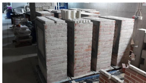
Fig. 25 – Paredes de alvenaria de tijolo
