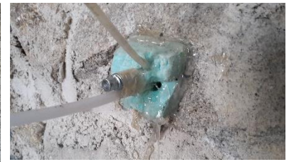
Fig. 54 – Detalhe da fixação do conjunto com cola quente
