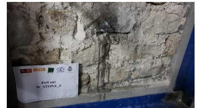
Fig. 57 – Parede pronta para realização do pull out , após secagem de 48 horas
