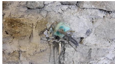
Fig. 56 – Detalhe de amarração das pontas dos tubos
