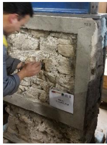
Fig. 52 – Molhagem do furo, para não absorver a água do grout
