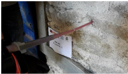
Fig. 46 – Aplicação de resina
