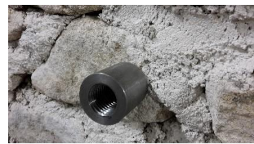
Fig. 402 – Detalhe da conexão mecânica
