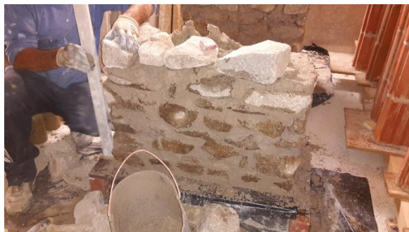
Fig. 28 – Execução da alvenaria de pedra
