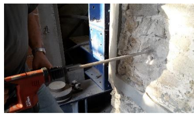
Fig. 50 – Execução do furo na parede com broca de 20mm
