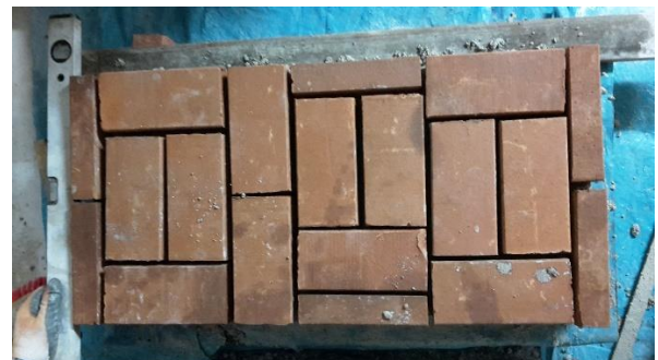
Fig. 29 – Execução da alvenaria de tijolo
