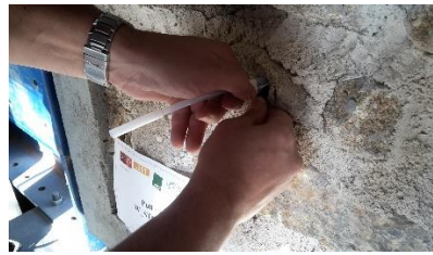
Fig. 53 – Introdução do conjunto no furo
