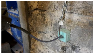
Fig. 55 – Detalhe da injeção de grout
