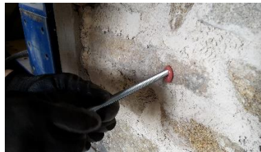
Fig. 47 – Colocação do conector
