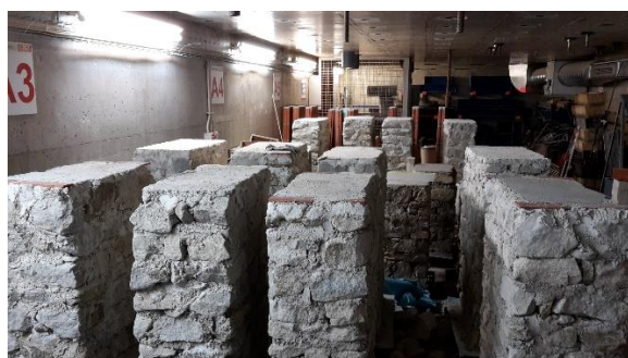
Figura 24 – Paredes de alvenaria de pedra
